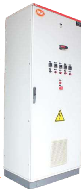
Painel Elétrico de comando e proteção
